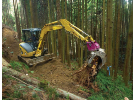
ザウルスロボによる作業道開設
